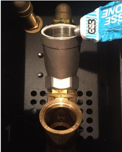
Applicare uno **strato sottile** di grasso siliconico sull'attacco di ogni filtro. Questo faciliterà la successiva operazione di smontaggio. Il **grasso non deve entrare nel circuito**.
