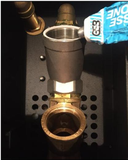
Tragen Sie **eine dünne Schicht** Silikonfett auf die Dichtungsfläche beider Filter auf. Dadurch lassen sich die Filter das nächste Mal leichter herausnehmen. **Das Fett darf nicht überquellen und in den Kreislauf gelangen.**
