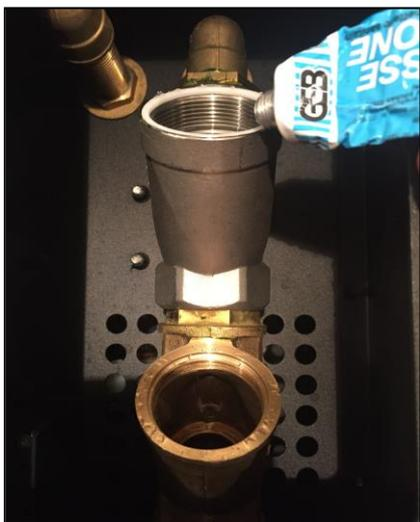
Appliquez **une fine couche** de graisse aux silicones sur la portée du joint de chaque filtre. Cela facilitera le prochain démontage. **La graisse ne doit pas débordée dans le circuit.**
